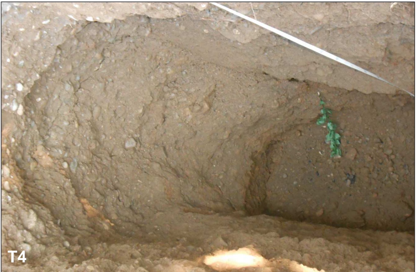
Foto 14 Trincea T4: particolare stratigrafico (profondità di scavo = circa 3m dal piano campagna)
