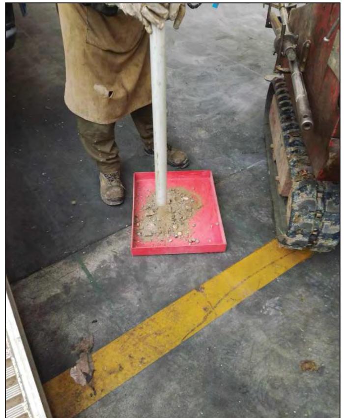
Foto 19 Sondaggio S1, particolare estrazione terreno.
