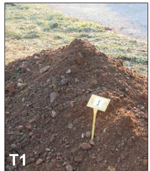
Foto 5 Trincea T1: particolare terreno scavato attorno 3m di prof.
